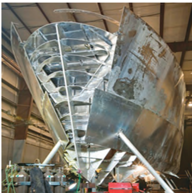
شکل ۲۳- سازهٔ سینهٔ یک شناور در حال ساخت
